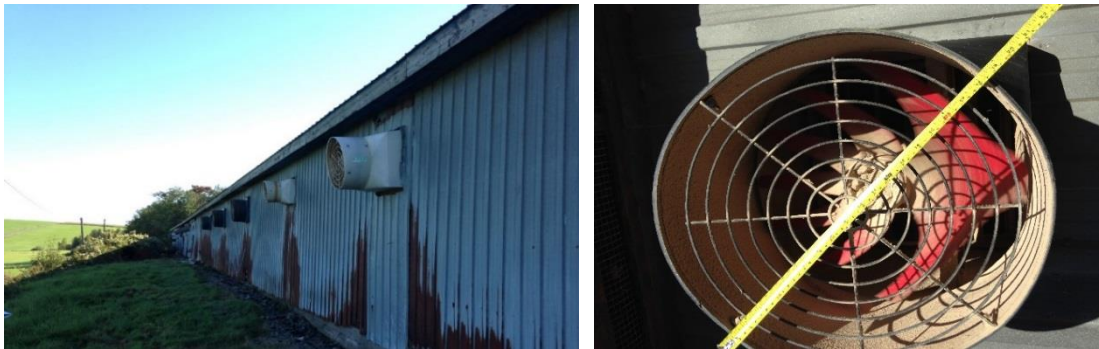
Figure 10 Étape de reconnaissance du lieu de mesure – Bâtiment L0 – entièrement latté
