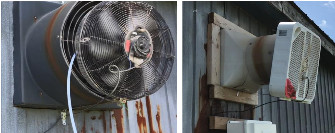
Figure 12 Installation de l'équipement de mesure du débit d'air pour le bâtiment L0 – entièrement latté
