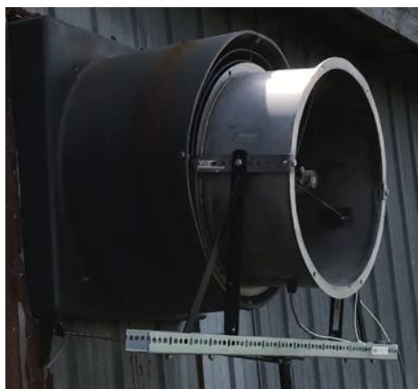
Figure 2 Adaptation en aluminium de l'hélice libre
