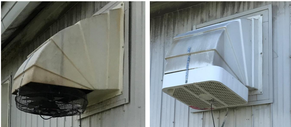
Figure 13 Installation de l'équipement de mesure du débit d'air pour le bâtiment PL0 – partiellement latté
