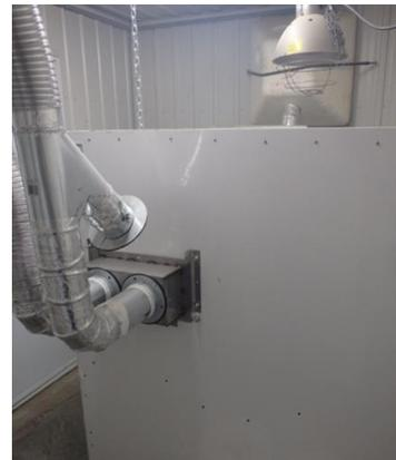
**Figure 3. Conduites permettant d'aspirer et d'acheminer l'air selon les différents essais : a) valve de rejet de surplus d'air dans la mini-pouponnière; b) prise d'air dans la pouponnière contaminée au vSRRP; c) sortie du corridor d'air directement dans le parc de trois porcelets dans la mini-pouponnière**
