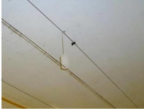
**Figure 16. Lignes de décharge d'ions avec pointes et isolateur du système d'ionisation**
