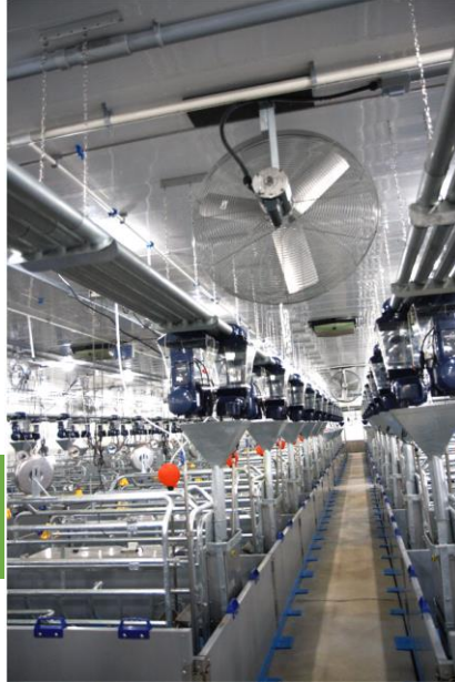
Recirculateurs 28'' à vitesse variable en mise bas
