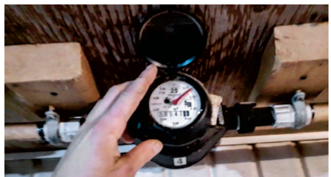
Compteur d'eau mécanique (modèle M25 en polymère, diamètre de 5/8" X 3/4").
