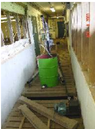
Figure 15 . Vue d'ensemble du montage
