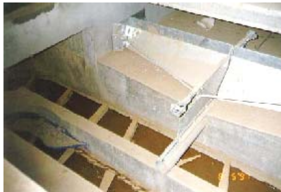
Figure 9 . Vue de la décharge du dalot en « V » vers la chaîne à écurer
