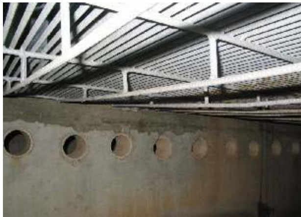
Figure 7 . Perforations des conduites pour l'extraction basse
