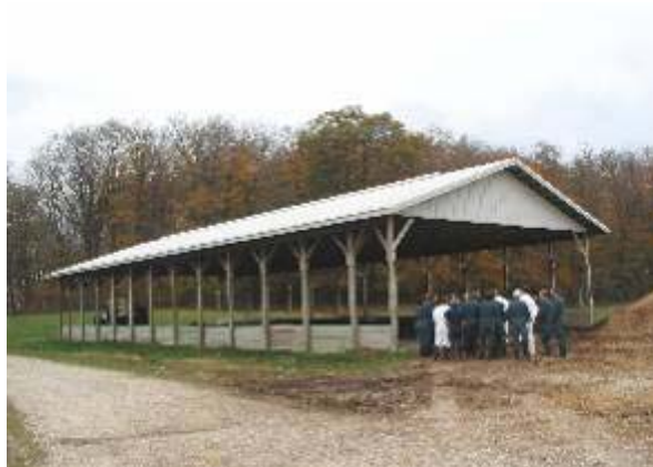
Figure 11 . Plate-forme de compostage à la ferme
