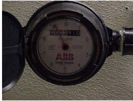
Figure 14 : Compteur d'eau ABB modèle C700
