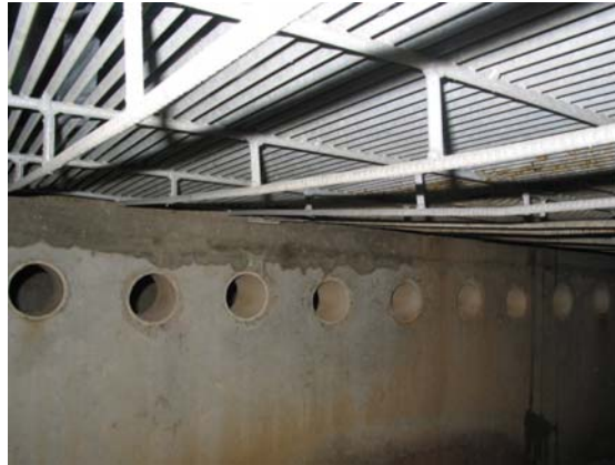
Figure 4 : Perforations du mur pour l'extraction basse
