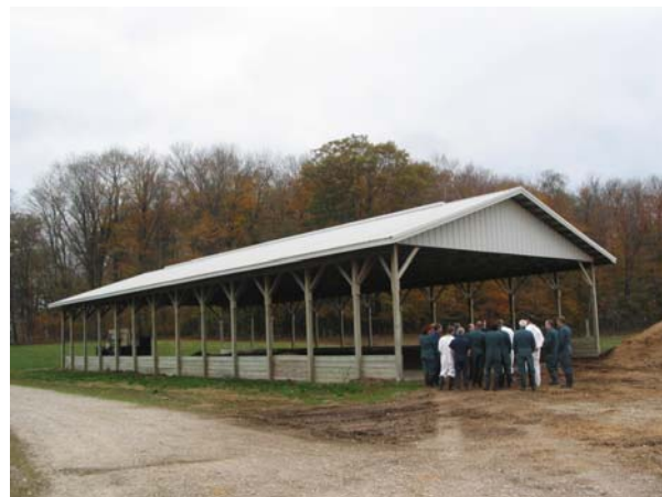
Figure 11 : Plate-forme de compostage à la ferme
