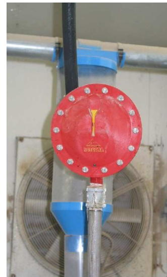
Figure 4 : Valve à diaphragme VR-H
