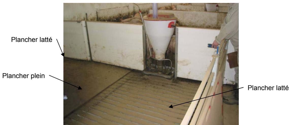
Figure 5-1. Zone de confort en plancher plein
