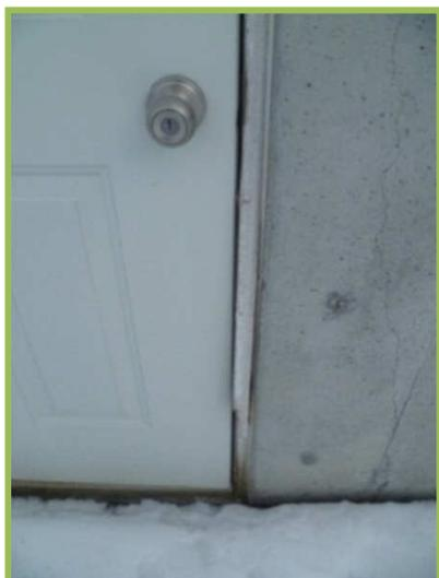
**Figure 17** Cadrage de porte non étanche permettant une infiltration d'air et devant être remplacé
