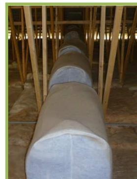
Figure 11 Filtres antimicrobiens de type « dôme » munis de préfiltres installés sur des entrées d'air modulaires
