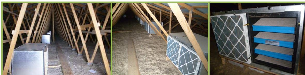
Figure 9 Caissons de filtration pour filtres mécaniques installés sur des entrées d'air modulaires
