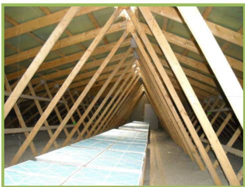
Figure 13 Filtres mécaniques installés sur une entrée d'air linéaire continue
