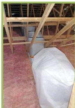
Figure 10 Filtres antimicrobiens de type « cubique » installés sur des entrées d'air modulaires
