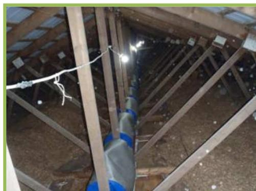
Figure 14 Filtres antimicrobiens de type « dôme » installés sur une entrée d'air continue
