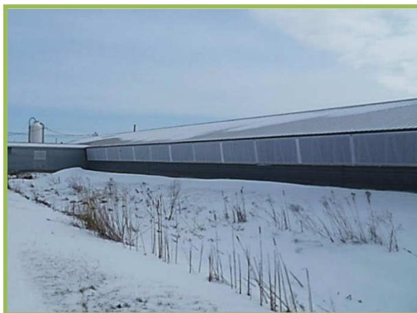
**Figure 7** Bâtiments munis d'un système de filtration d'air antimicrobien de type « rideau »
