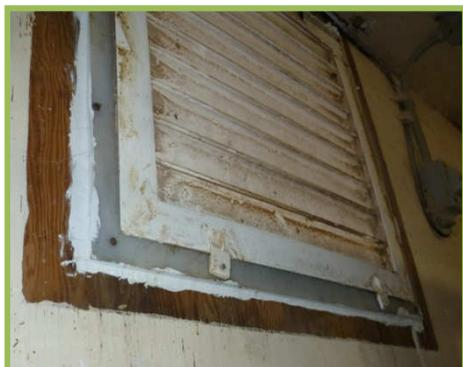
**Figure 19** Pourtour d'un boîtier de ventilateur ayant été calfeutré afin d'éviter l'infiltration d'air
