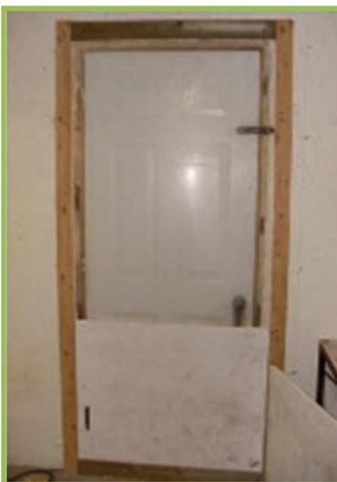
**Figure 18** Porte étanchée avec un polythène et des lattes sur le pourtour<sup>b</sup> afin d'éviter l'infiltration d'air .
