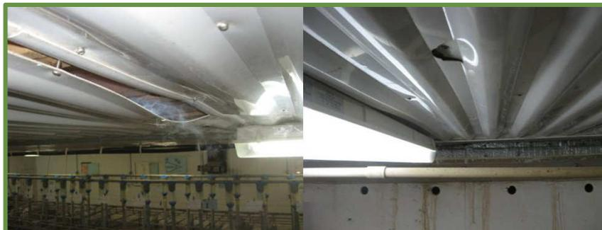
**Figure 16** Bris du plastique ondulé permettant une infiltration d'air
