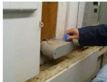
Figure 27 Infiltration d'air par l'orifice du mur créé par un boîtier de raccord en PVC devant être colmaté avec du scellant approprié
