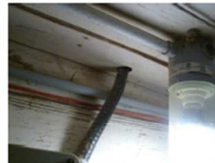
Figure 26 Pourtour de fil électrique permettant une infiltration d'air devant être colmaté de façon appropriée
