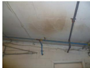
Figure 25 Le pourtour de ces conduites de propane doit être calfeutré avec un scellant approprié (Flextra)
