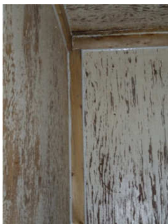
Figure 19 Joints mur-plafond et mur-mur étanchés par une latte et du scellant approprié
