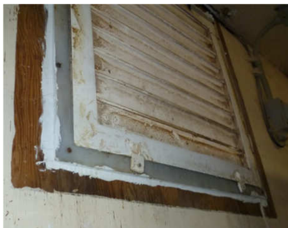
Figure 36 Pourtour d'un boîtier de ventilateur ayant été calfeutré
