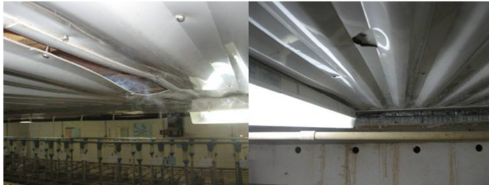
Figure 41 Bris du plastique ondulé
