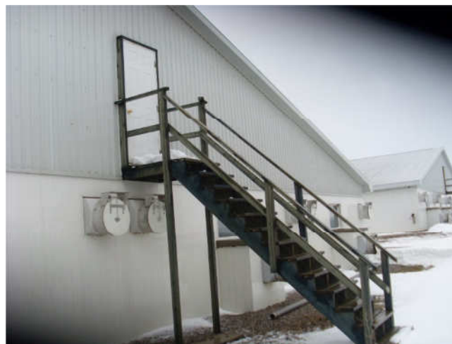
Figure 9 Exemple d'accès à l'entretoit par l'extérieur
