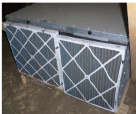
Figure 12 Préfiltre n'étant pas correctement maintenu en place par les attaches (le préfiltre tend à descendre lorsque les attaches sont situées sur les côtés du préfiltre)
