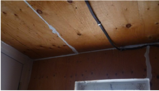
Figure 21 Scellant appliqué sur les joints entre les panneaux de contreplaqué
