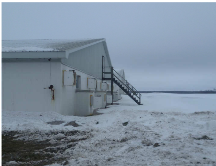
Figure 49 Accès vers l'entretoit par l'extérieur
