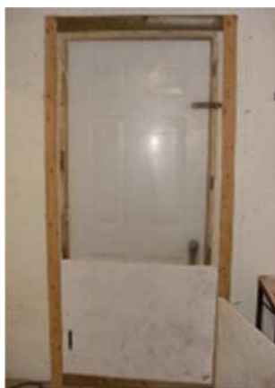
Figure 16 Porte étanchée avec polythène et lattes sur le pourtour
