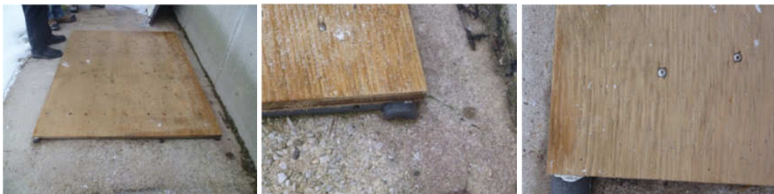
Figure 45 Couvert étanche d'une station de pompage
