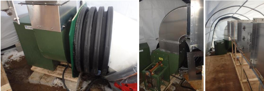
**Figure 11** Jonction entre la sortie du puits et le ventilateur pompant l'air. Aperçu de la conduite avant la pose de l'isolation
