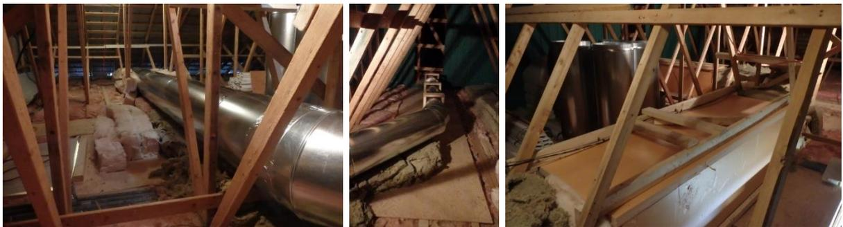
Figure 16 Conduite de raccordement dans l'entretoit avant et suivant la pose de l'isolant
