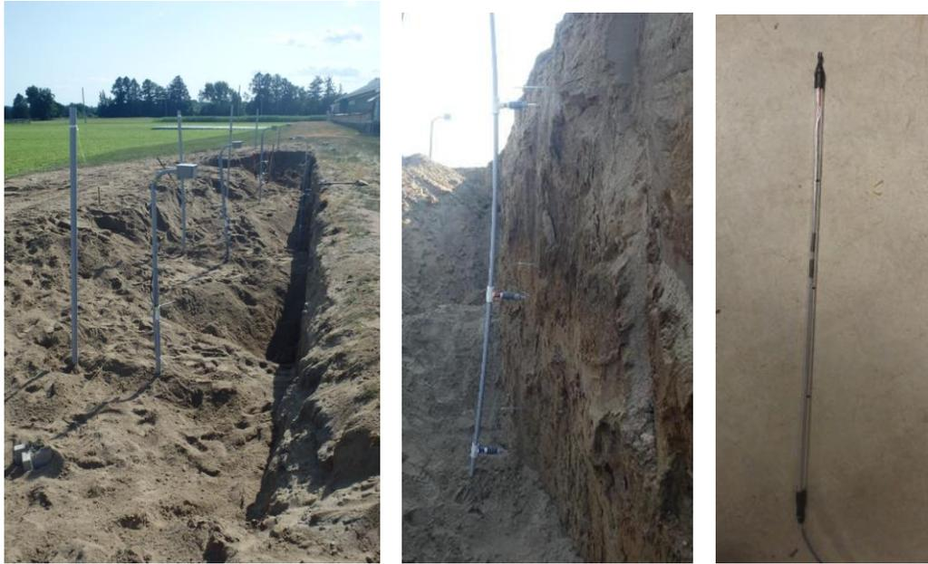
Figure 19 Section d'instrumentation, sol non remanié et sonde de température
