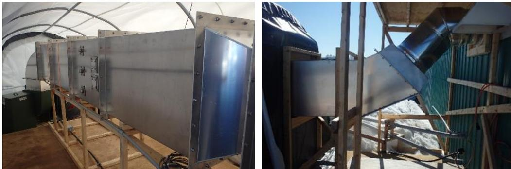
Figure 14 Photos de la conduite de raccordement extérieure avant l'isolation avec des panneaux rigides
