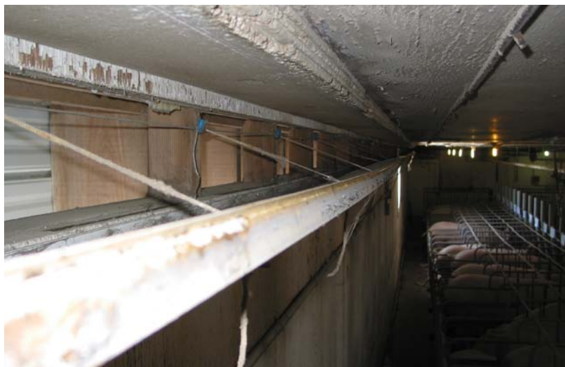
Figure 12 Vue intérieure d'une entrée d'air avec ouverture continue au mur
